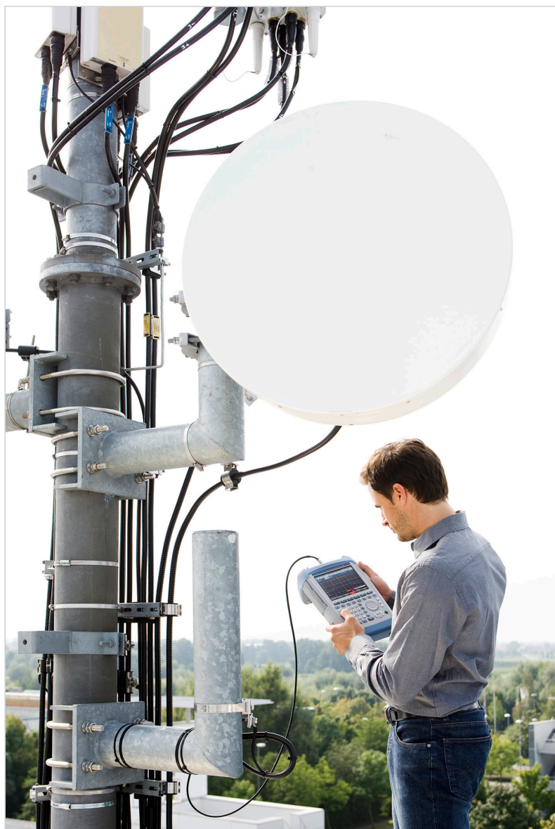
送信局の設置／保守中のR&S®FSH操作
