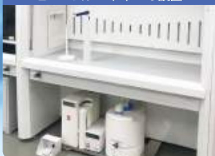
ヒュームフード下への設置
