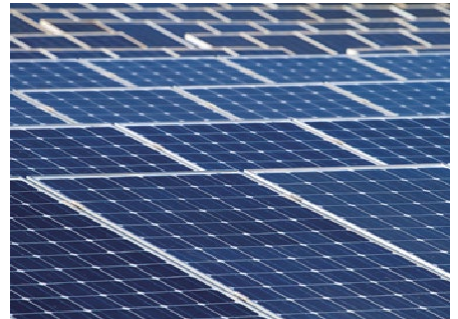
太陽光発電システムの負荷テスト
