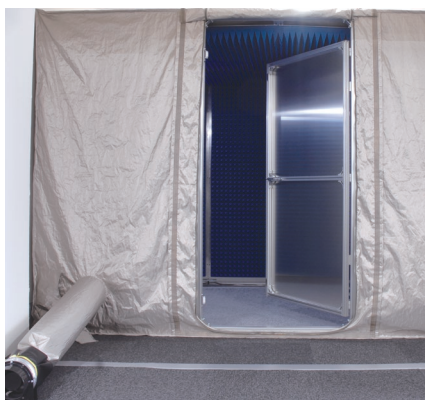
正面扉 取付時
