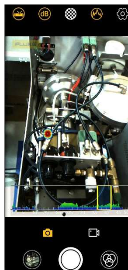
複雑な設備配管の気密性試験
